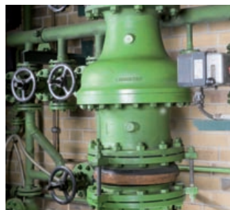
Von links nach rechts: Kühlturmwassererzeugung, Versorgungspumpen, Beispiel einer alten Rückschlagklappe
