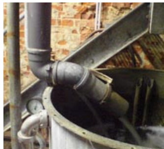
Von links nach rechts: Kesselspeisewasserpumpen, Pumpensystem Betriebswasser warm, Rücklauf vom Kühlturm in den Sammelbehälter
